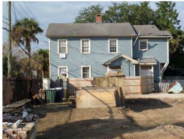
6 Gadsden Street - Side
